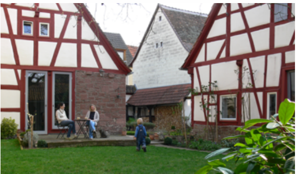
Ein gutes Beispiel für erfolgreiche Sschimmelbekämpfung: das Haus in der Dürrengasse 3 vor und nach der Sanierung
