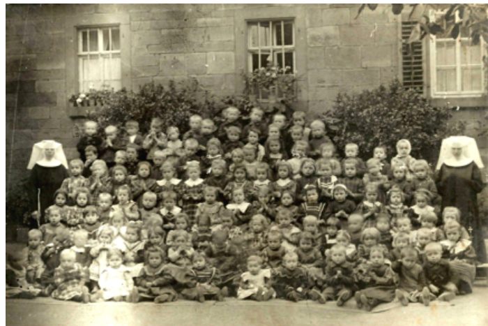
Auf diesem Foto von 1909 sieht man, dass unter dem Verputz im Erdgeschoß ein hochwertiger Werksandsteinbau steckt.
